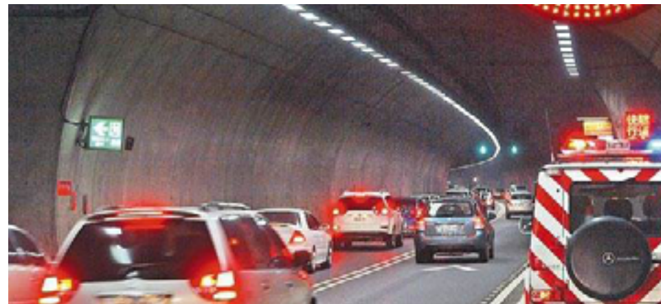
▲隧道內之交通阻塞路況
